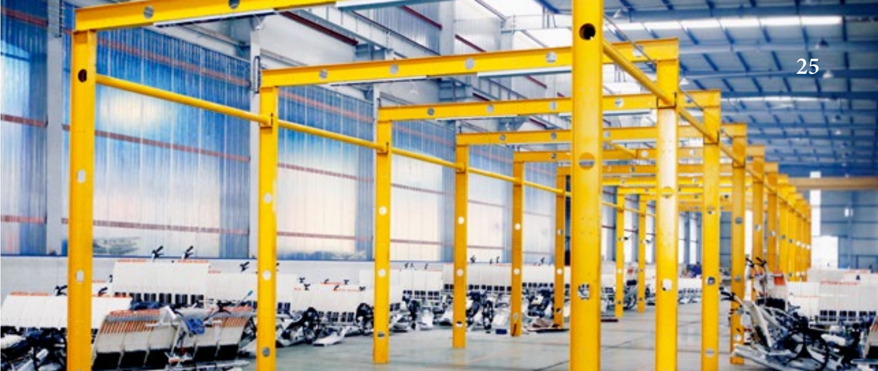
绍兴分行客户 浙江蓝能燃气设备有限公司厂房
